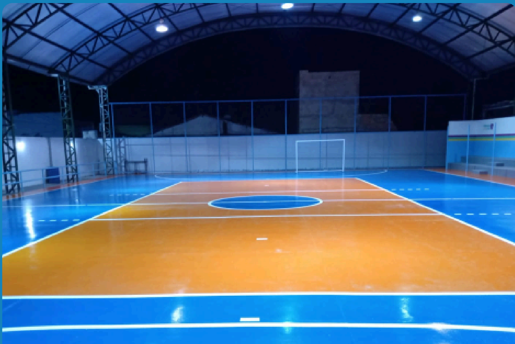
QUADRA POLIESPORTIVA - MALHADOR (SE)
